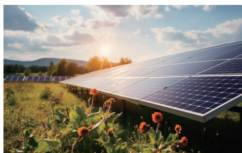
四川远通毛儿盖第二批214MW项目
