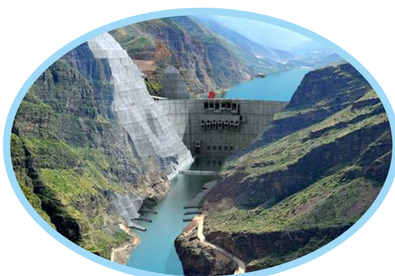
白鹤滩水电站
