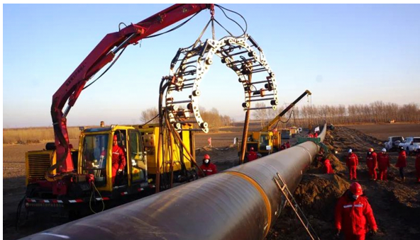
施工现场铺设的油气管
