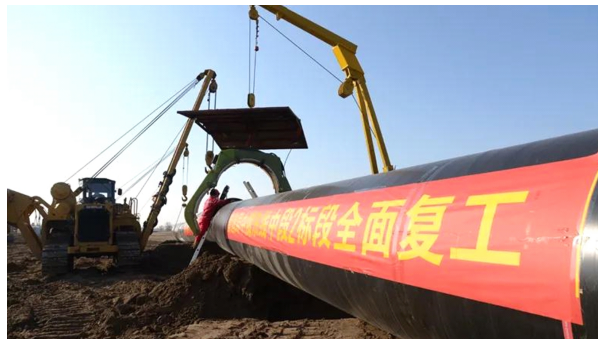
施工现场铺设的油气管
